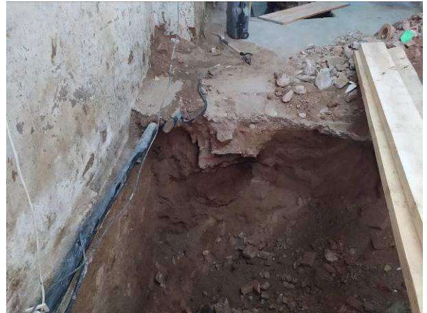
52. Vista general del Pou de fonamentació 9
