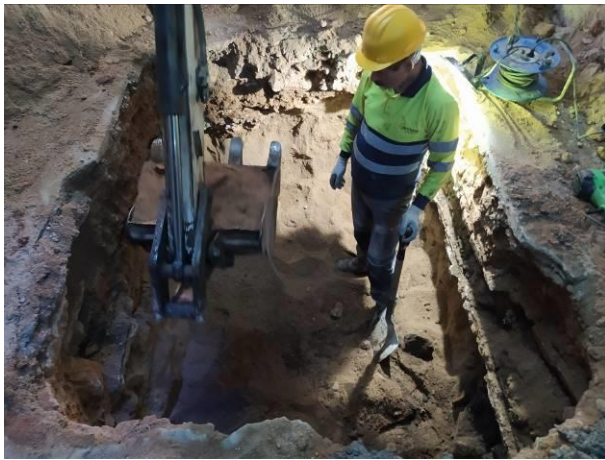
49. Treballs d'obertura del Pou de fonamentació 8
