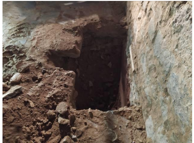
34. Obertura del Pou de fonamentació 5
