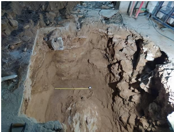
45. Vista del pou UE 31 al Pou de fonamentació 7
