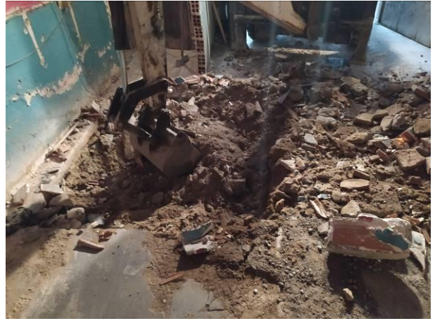
32. Obertura del Pou de fonamentació 4
