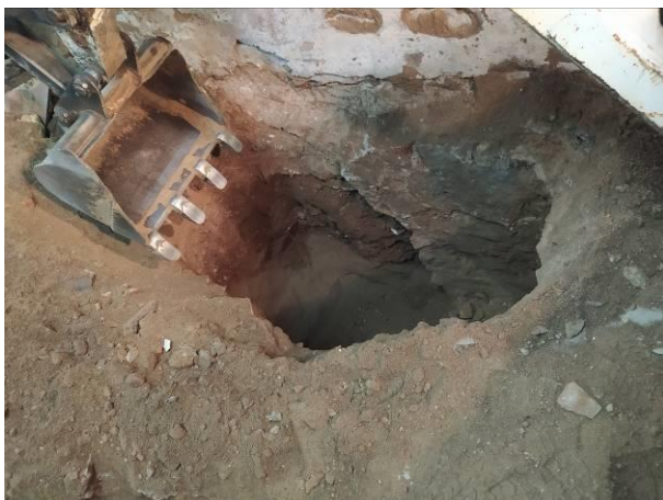
53. Obertura del Pou de fonamentació 10
