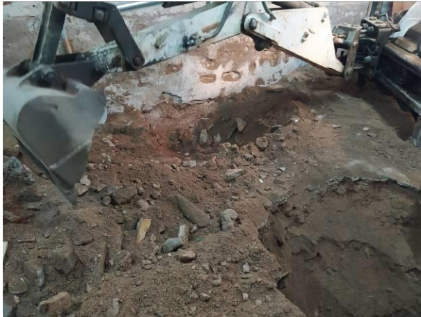
51. Obertura del Pou de fonamentació 9
