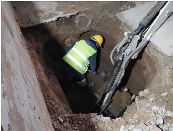
39. Treballs d'obertura del Pou 6
