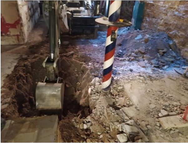
25. Obertura del Pou de fonamentació 2
