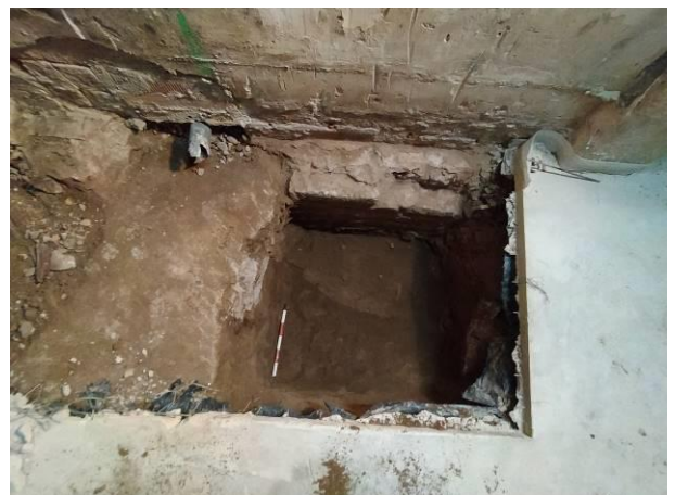
12. Vista general de l'ampliació i fonamentació UE 55
