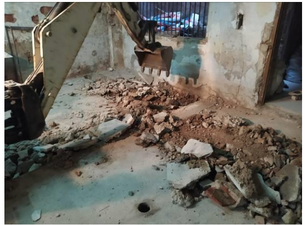
38. Obertura del Pou de fonamentació 6
