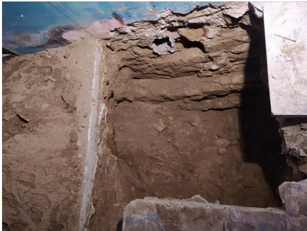
9. Vista general del Pou de fonamentació 1
