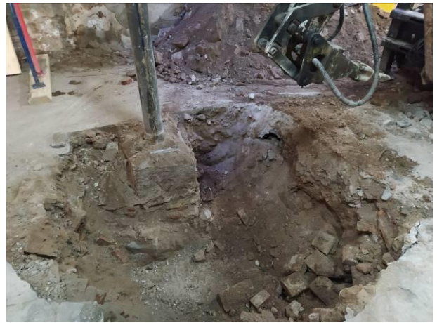
44. Treballs d'obertura al Pou de fonamentació 7
