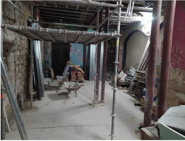
1. Vista general de la crugia SW
