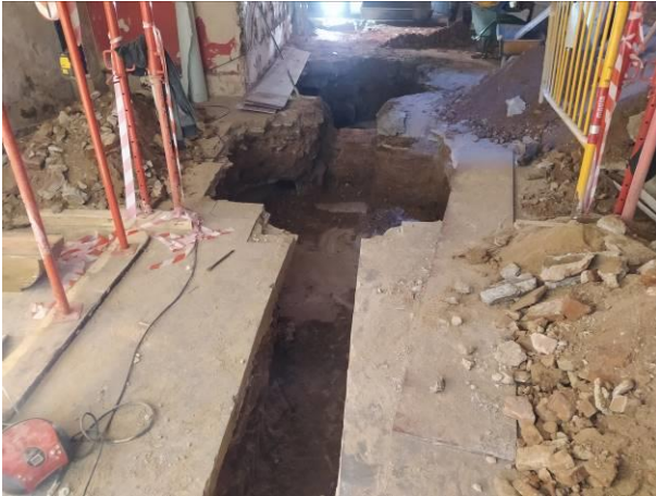
27. Pous de fonamentació 2 i 3 al centre de la crugia SW
