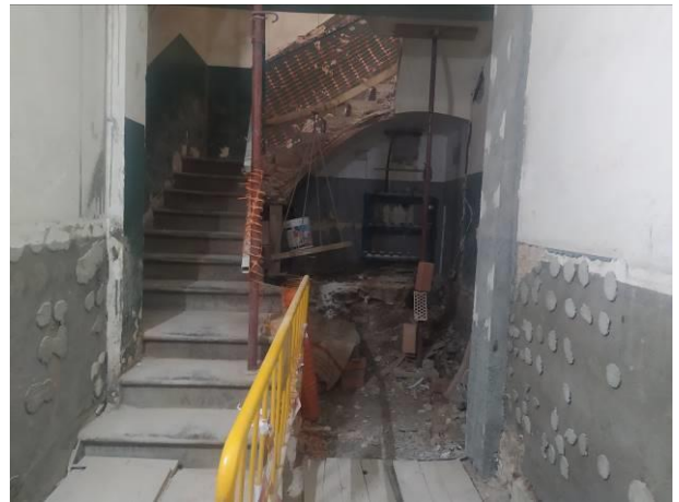
56. Vista general de les escales al centre de l'edifici
