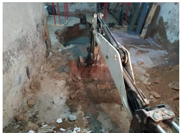
48. Obertura del Pou de fonamentació 8
