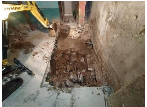
10. Ampliació del Pou de fonamentació 1
