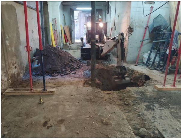
43. Obertura del Pou de fonamentació 7 al centre de la crugia
