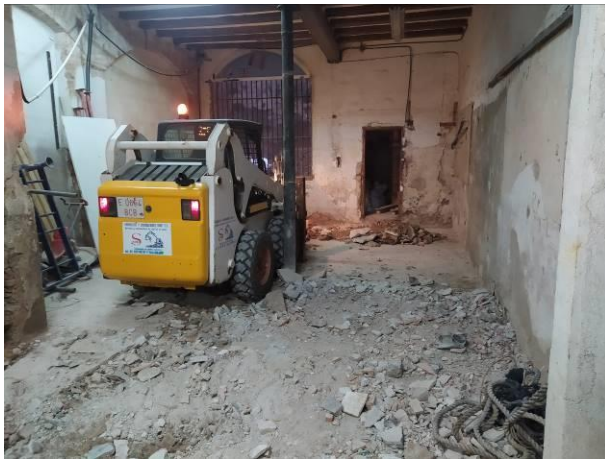
37. Vista general de la crugia NE
