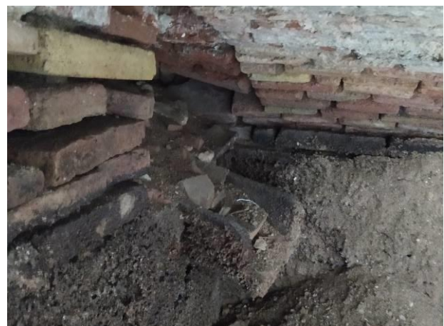
66. Desaigua a l'interior de la fossa sèptica UE 63
