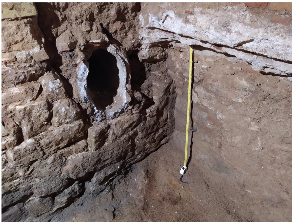
A l'esquerra mur UE 17 seccionat per UE 15 on s'hi recolza UE 19 (dreta).
