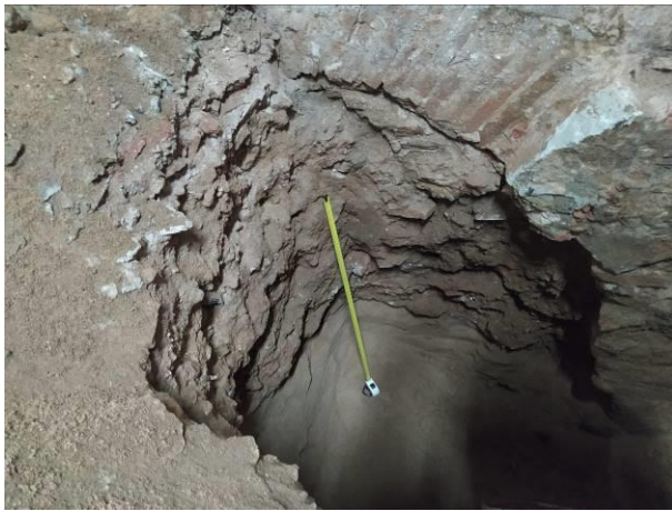
55. Detall de l'arc de descàrrega a la fonamentació UE 53
