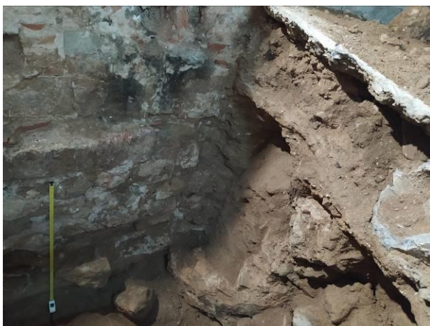
41. Fonamentació UE 21 i pou UE 24 seccionat per la fonamentació UE 48
