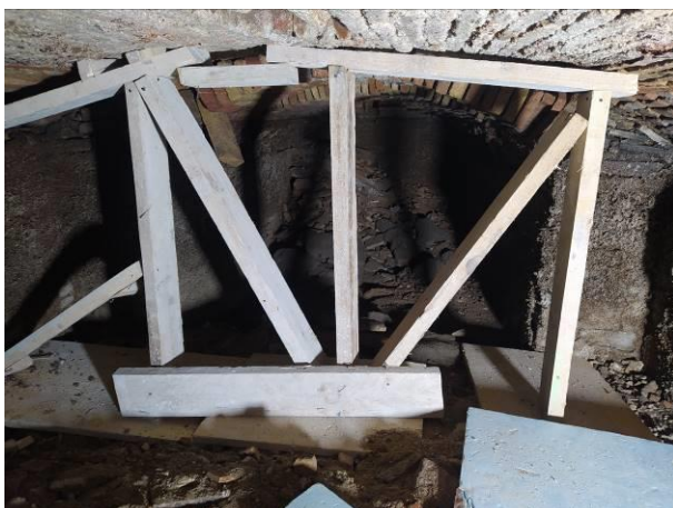
65. Interior de la fossa sèptica UE 63
