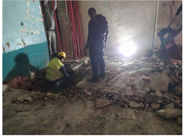
2. Obertura del Pou de fonamentació 1.
