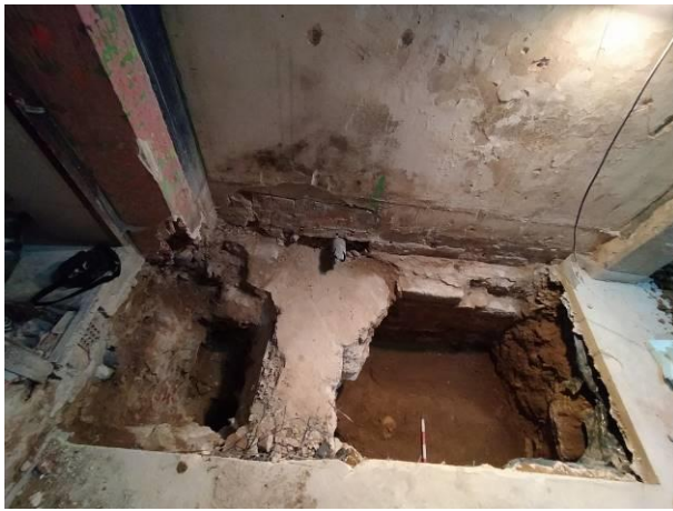
13. Vista general de l'ampliació del Pou de fonamentació 1
